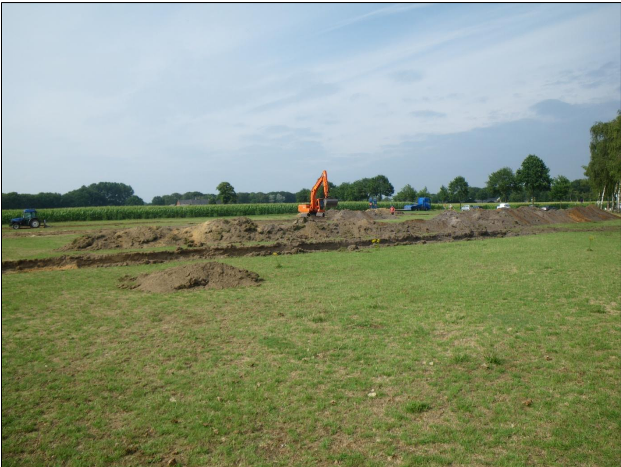
Figuur 2: sfeerfoto van de werkzaamheden.
